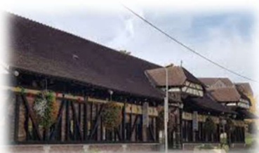
La Maison de quartier
