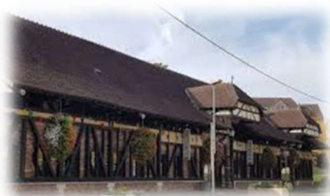
La Maison de quartier
